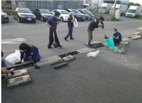
事務所前の排水溝の清掃
